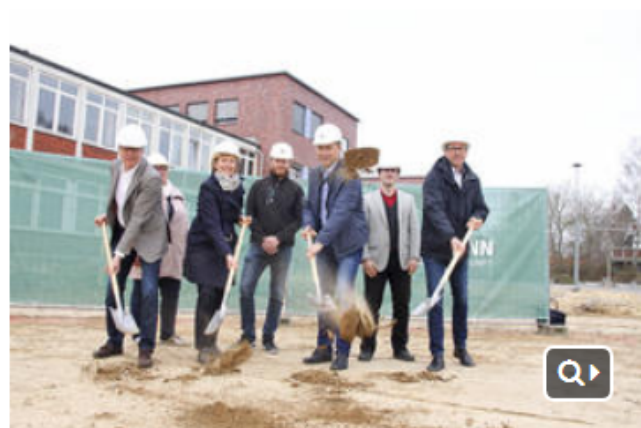
Symbolischer Baustart (v. li.): Architekt Gerd Wichers, Schulausschuss-Vorsitzende Inge Bardenhagen, Bürgermeisterin Silvia Nieber, Bauleiter Christoph Lührs, Oberbauleiter Thomas Rosenow, Architekt Marco Granzow und Schulleiter Volker von Loh
