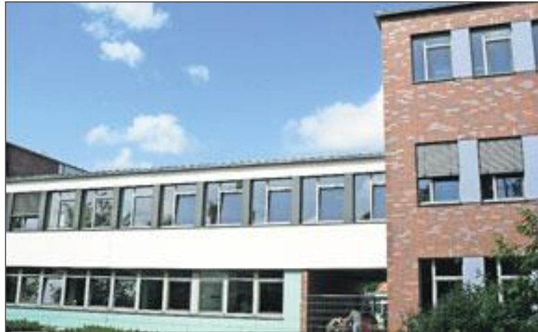
Trakt A und B der Realschule Camper Höhe sind im ersten Bauabschnitt beinahe fertiggestellt und baulich und energetisch rundumrenoviert, innen wie außen.
