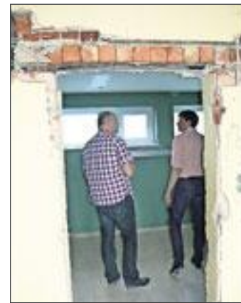
Schulleiter Volker von Loh (rechts) und Architekt Bernd Bieber passen noch durch die alten Türen. Doch weil die Menschen größer werden, sind die neuen Türen in der Realschule 2,13 Meter hoch.
